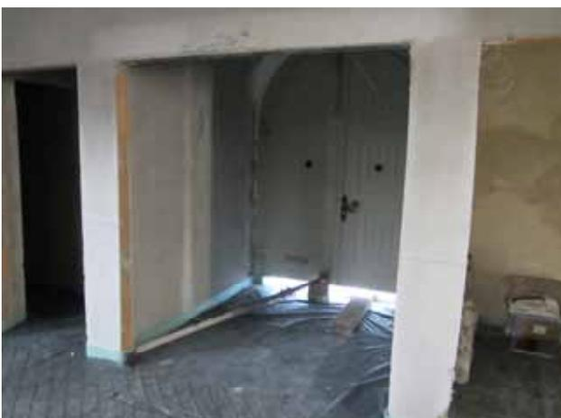
Die neuen Wände sind verputzt, das Fußbodenniveau ist aber noch tief, wie man gut an dem Türspalt sehen kann. Die Türen werden komplett neu gemacht und werden nach außen aufschlagen.
