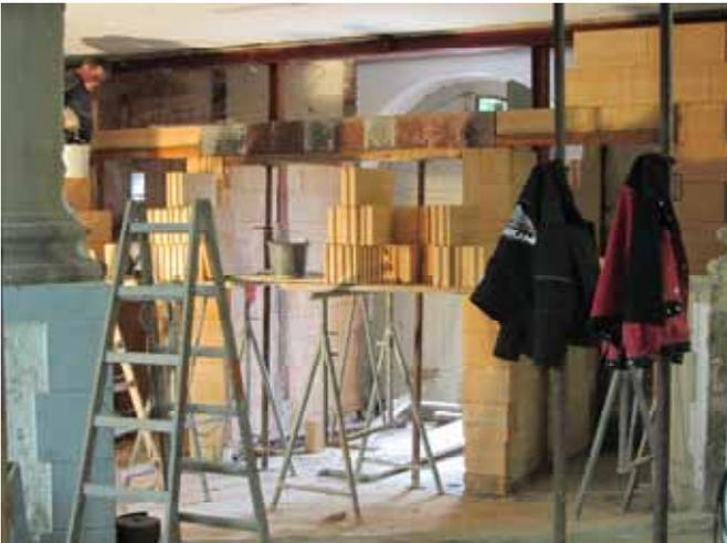
Die Wände in den Zwickeln werden versetzt und neu aufgemauert.
