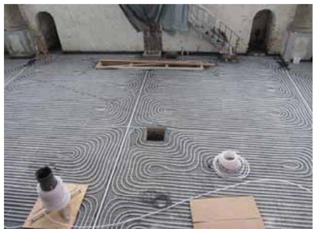
Nein, das sind keine Felszeichnungen oder Labyrinth, das sind die Heizschlaufen der Fußbodenheizung. Diese sind im November mit Estrich aufgefüllt worden und müssen im Dezember ruhen und aushärten.
