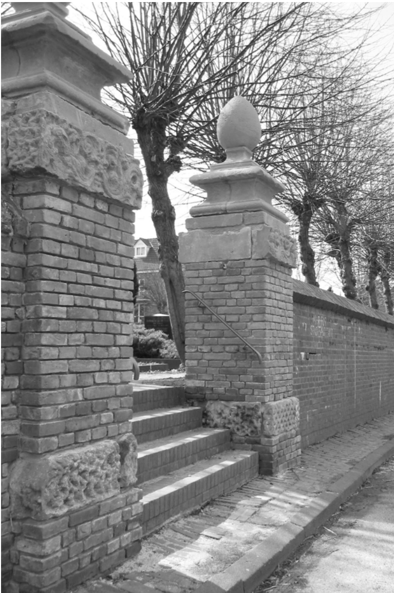
Treppenstufenanlage an der Osterstraße
