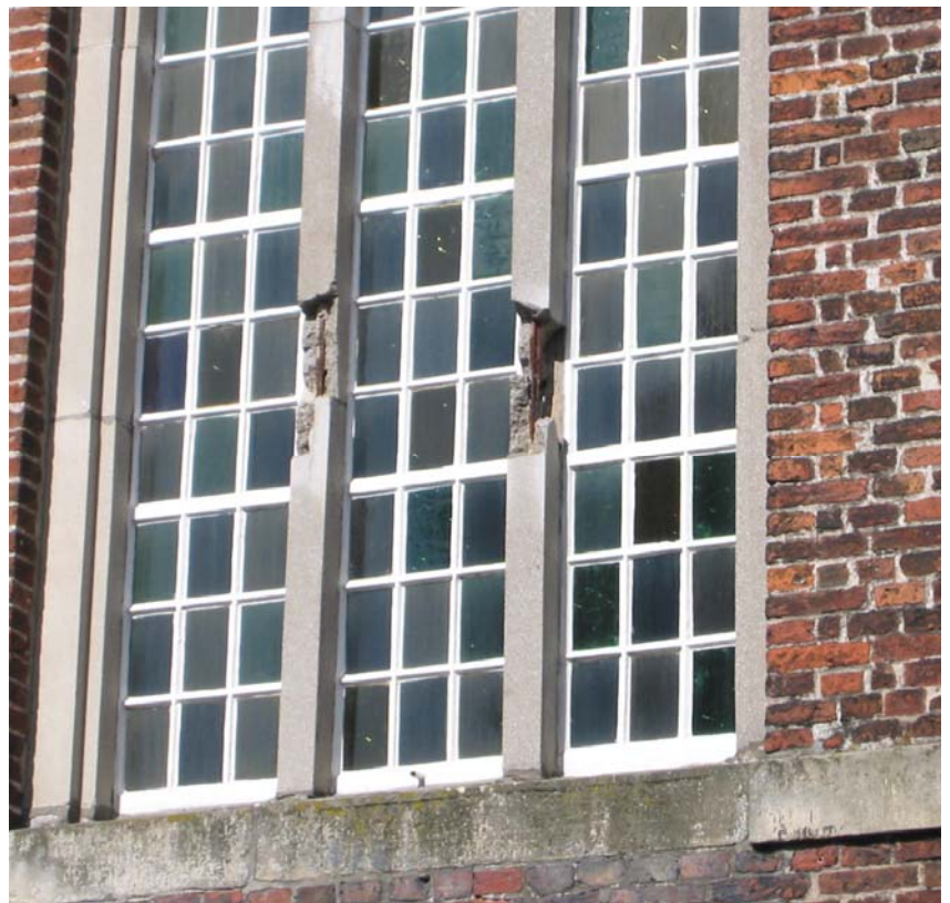
Schäden im Maßwerk an der Brückstraße
